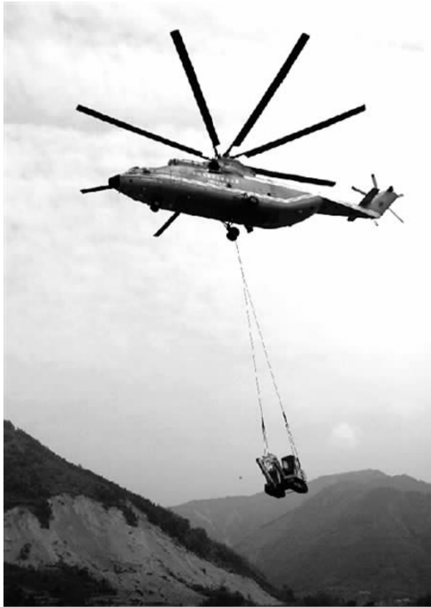
米-26 直升机在向唐山山堰塞湖坝顶吊运挖掘机
