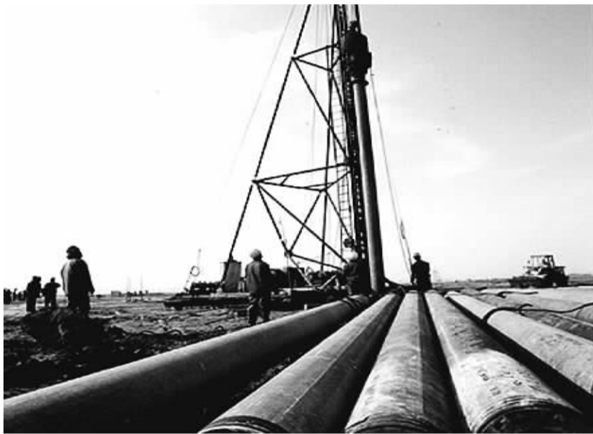
滨海新区施工现场
